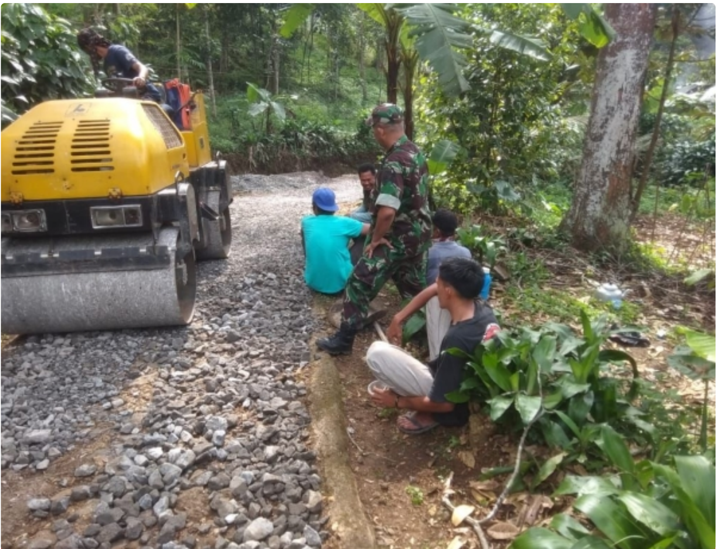
Babinsa Desa Pangkalan Monitoring Pembangunan Infrastruktur
