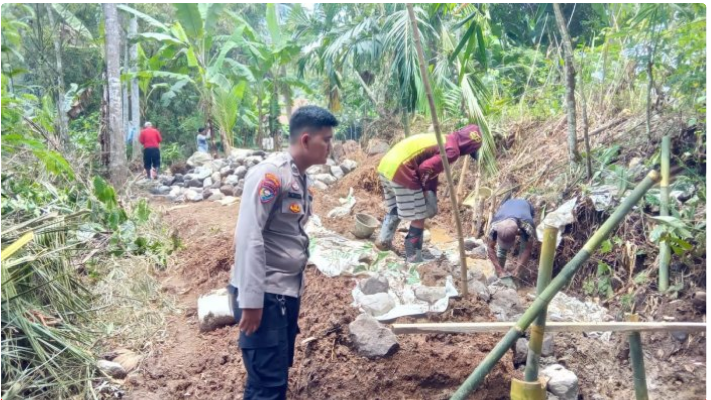
Bhabinkamtibmas Cijengkol Memantau Pembangunan Irigasi di Wilayah Desa
